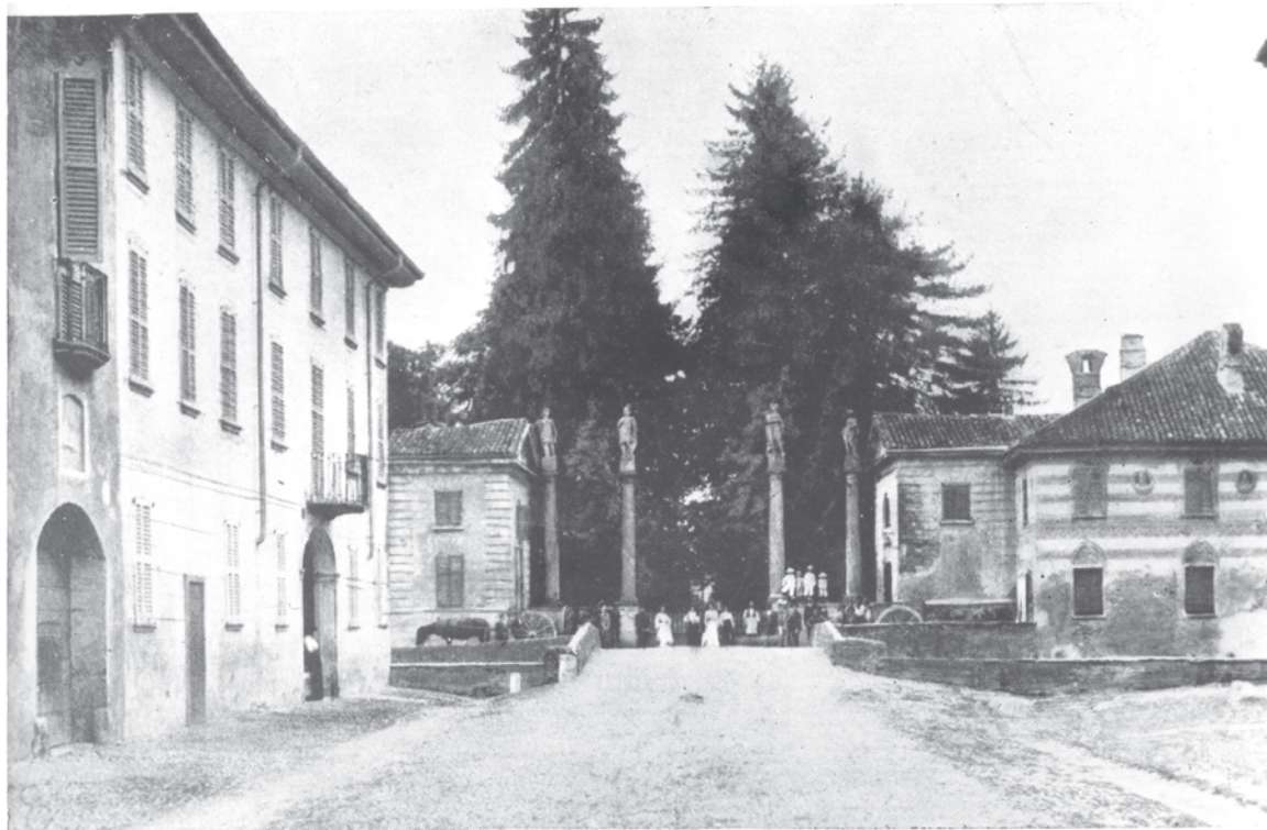
Cusano, Via Vittorio Emanuele (ora Via G. Matteotti). Ponte sul Seveso, ingresso al giardino di Palazzo Omodei
