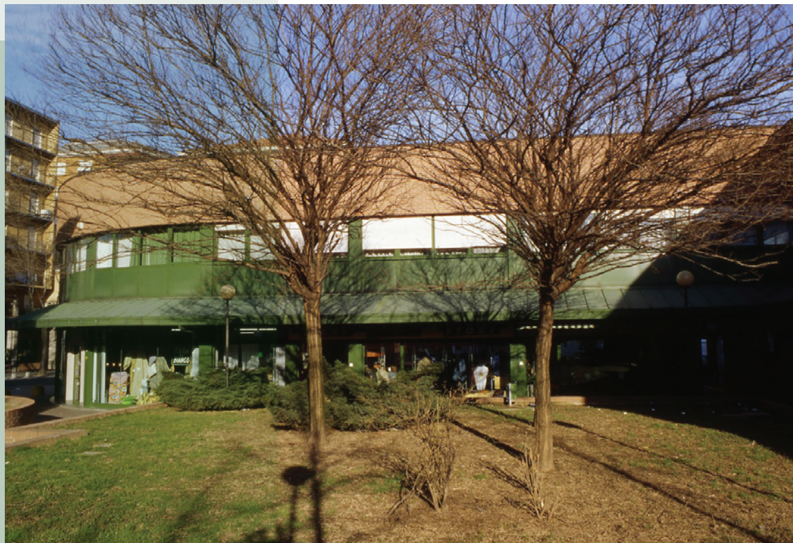
Edificio di via Matteotti 35, sede degli uffici della Cooperativa Edificatrice
